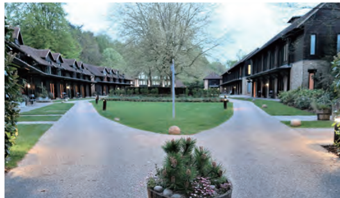
かつて馬小屋だった建物群を贅沢に改造した「Stable Cottage」は40室のコテージが並ぶ
