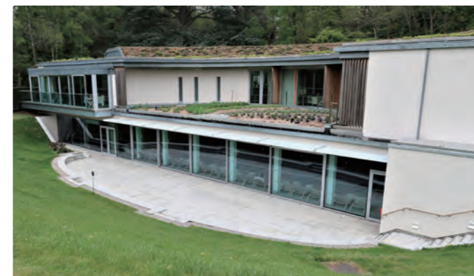
スパ施設「The Spa at Coworth Park」は、八つのトリートメントルームとヘルシーレストラン「Spatisserie」を用意し、Mansion House から離れた森の中に閑静な姿で佇んでいる
