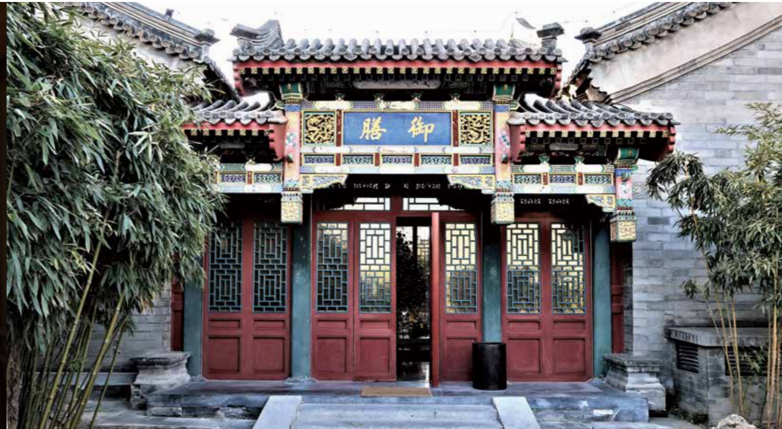
大きく『御膳』の文字が掲げられた風情あるレストラン棟。アマンサマーパレスの“食”の中心となる建物で、日本料理「Nama」、西洋料理「The Grill」の2軒のレストランが入る
