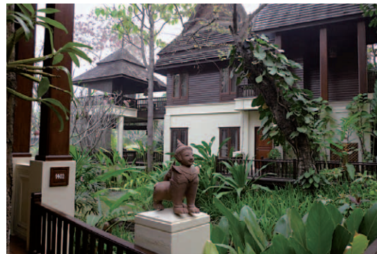
ライステラスに面したパビリオン棟。4つの客室から成る2階建てが基本で、それぞれ左右にUpperとLowerのパビリオンに分れ回廊で結ばれている。屋外ベランダの「Sala」も見える
