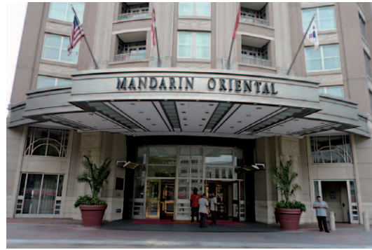
「Mandarin Oriental Washington DC」の正面エントランス。2004年開業のワシントンDCでは比較的新しいホテルだ
