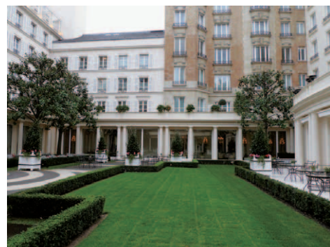
中庭ガーデン側から俯瞰した1階回廊と庭園側客室部分。右手にレストラン「Epicure」のテラス部分が見える
